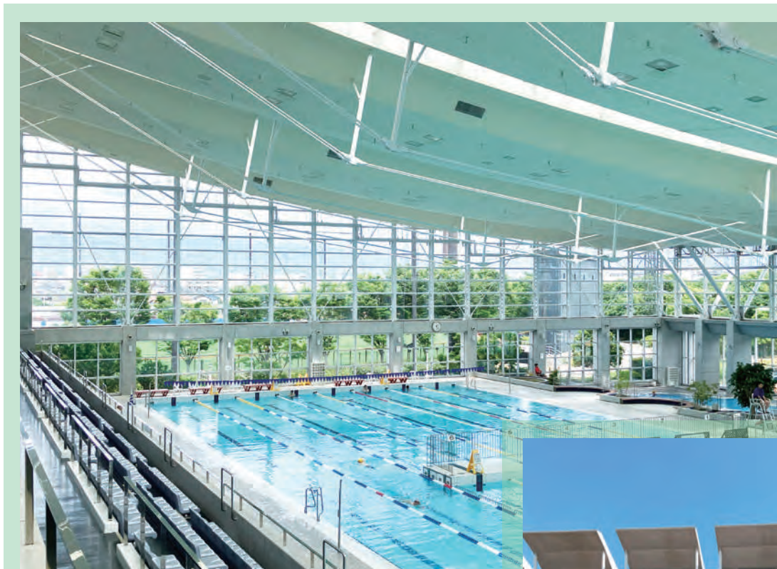
アクアパレットまつやま天井改修その他工事
