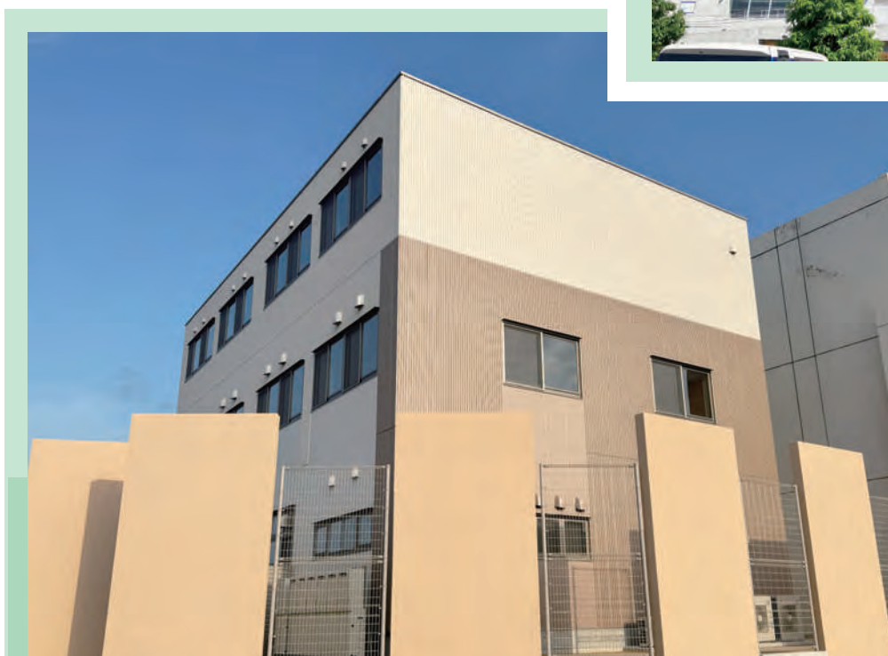
松山中央公園 多目的競技場 東棟 増築主体その他工事
