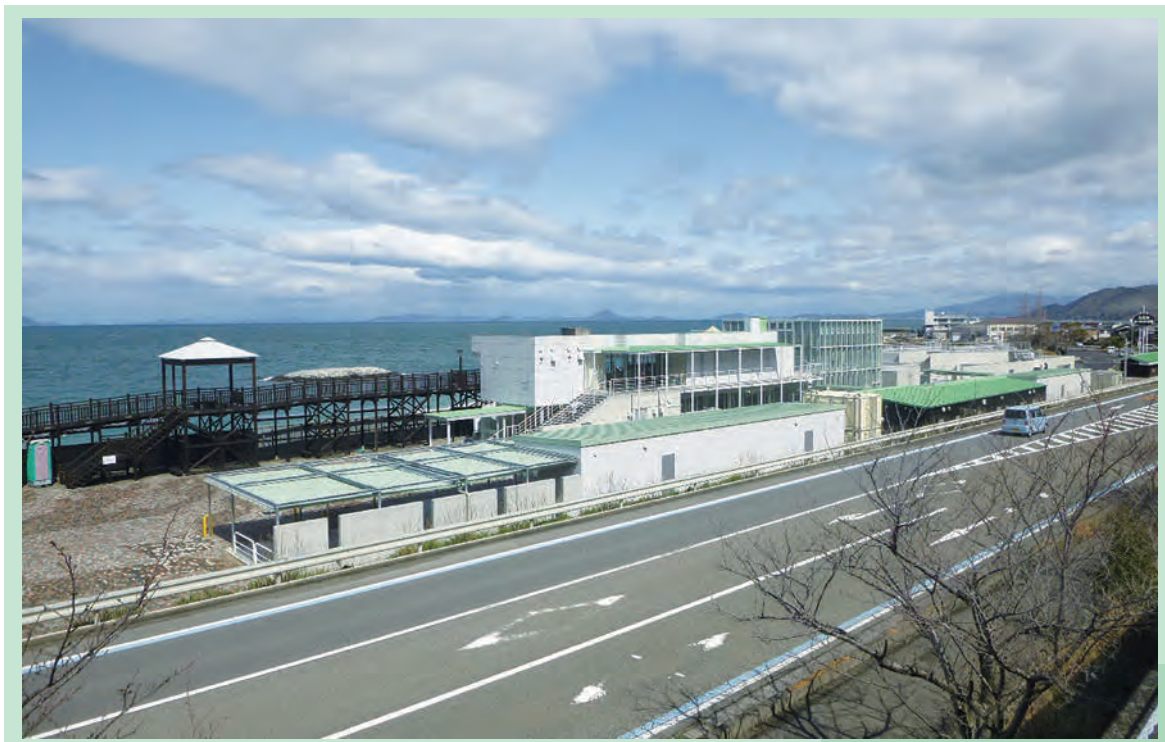
ふたみシーサイド公園改修建築
