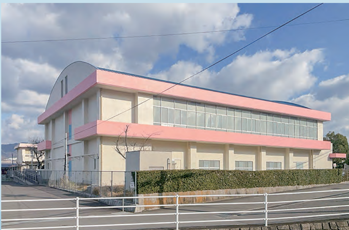
東温市立拝志小学校 屋内運動場長寿命化改修建築主体工事
