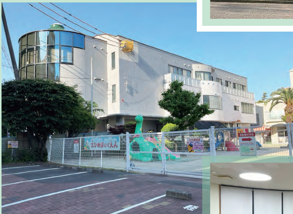
ハーモニープラザ外部改修その他工事
