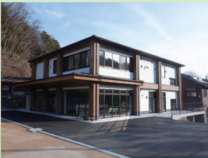
北条育成園 日中活動棟第2別館新築
