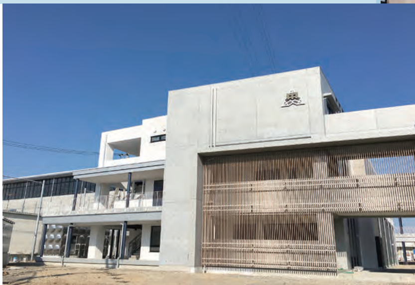
余土中学校武道場・プール棟
