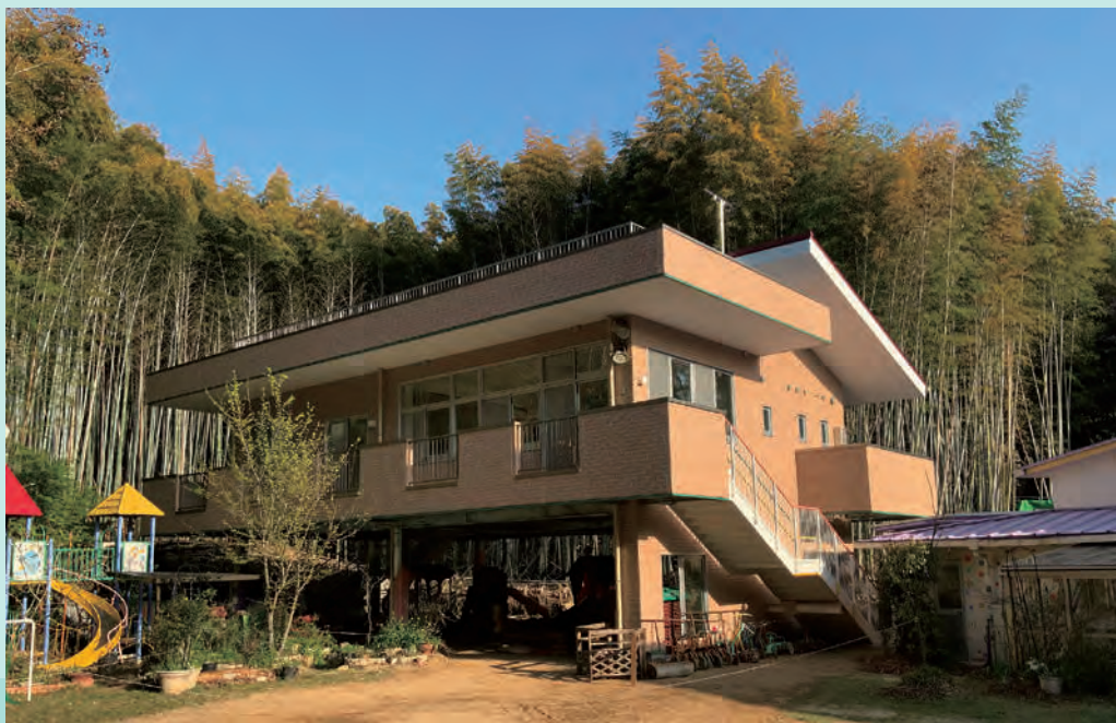
石手幼稚園遊戯場・多目的室増築
